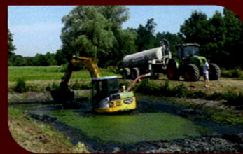
Pompage des boues
