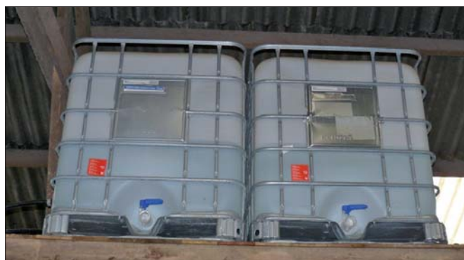
Cuves de stockage alimentant des bacs d'abreuvement par gravité
