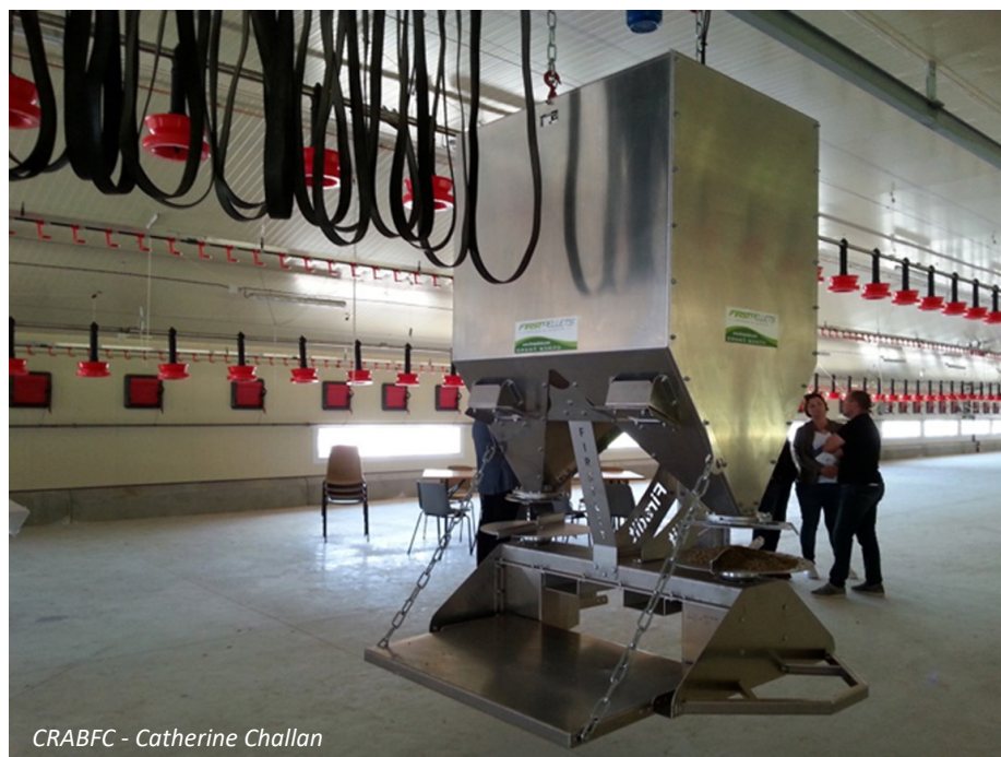
Distributeur de bouchons de paille pour la litière et éclairage naturel.
